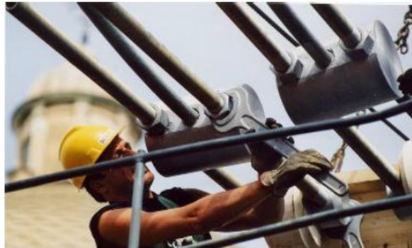
I tiranti utilizzati per la Torre di Pisa
